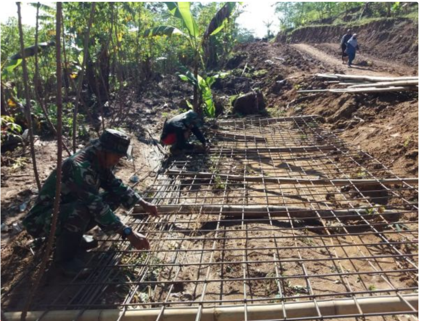
Anggota Satgas merakit kerangka plat beton
