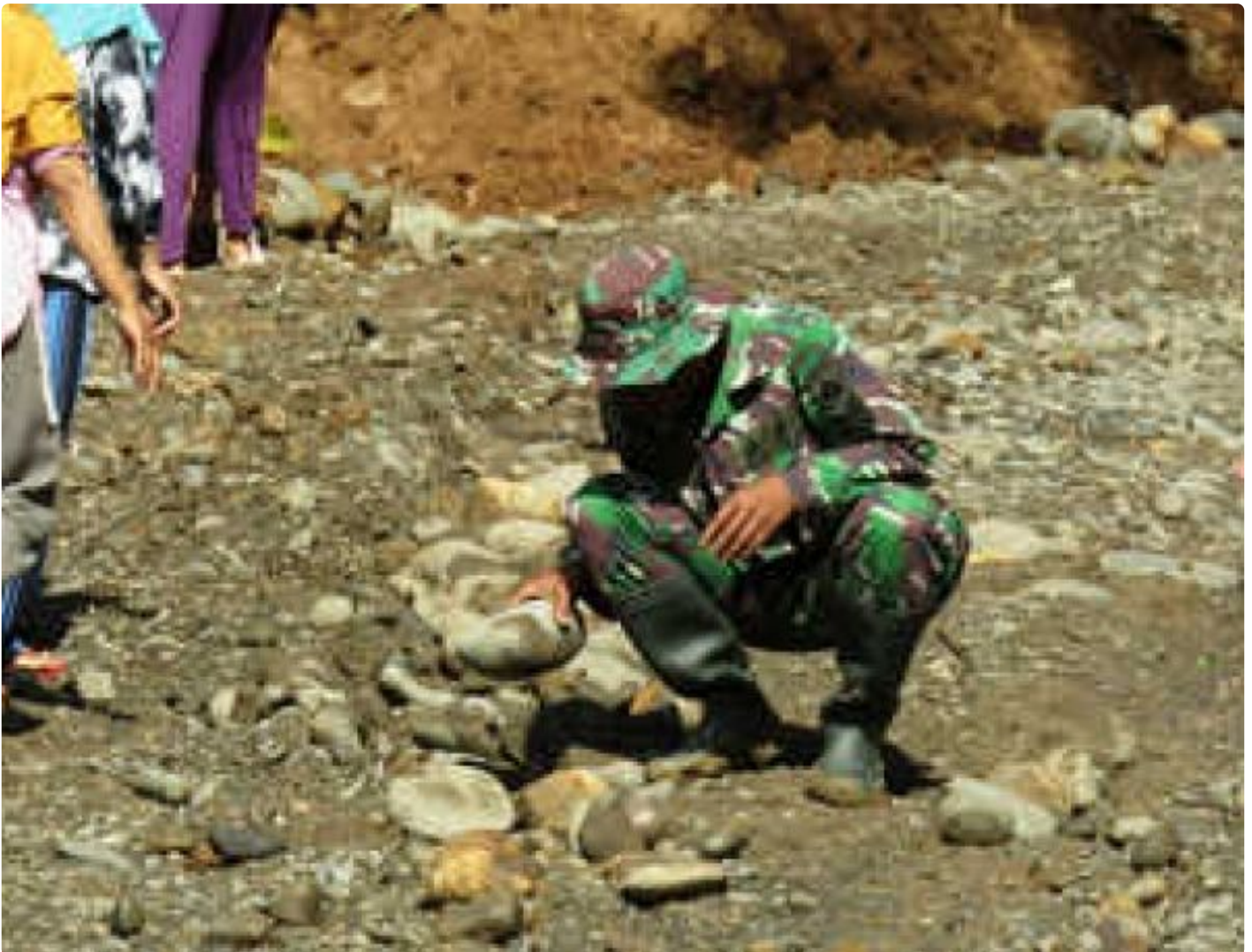
Satgas tata batu untuk pemadatan jalan baru
